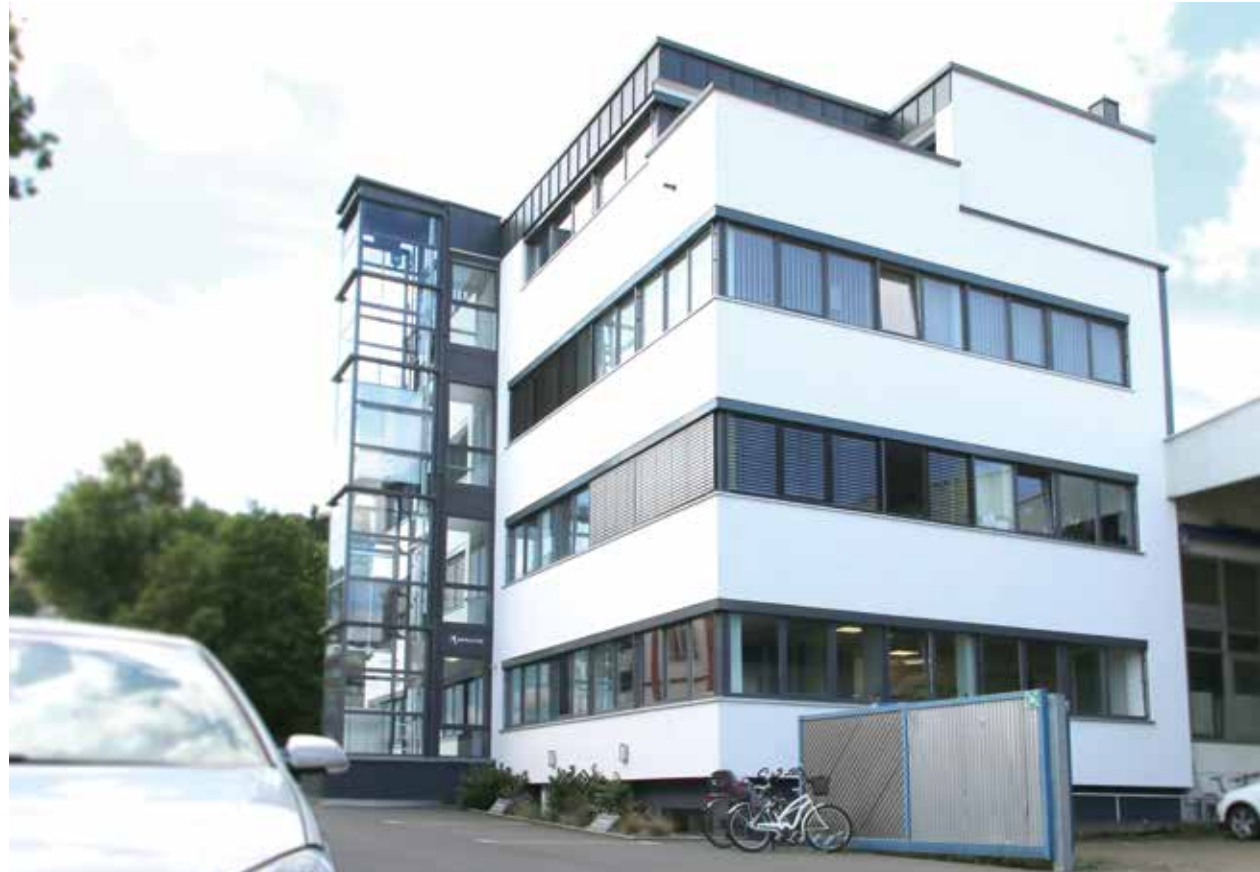
>> Bürogebäude Frankfurter Straße 96 Bestand
