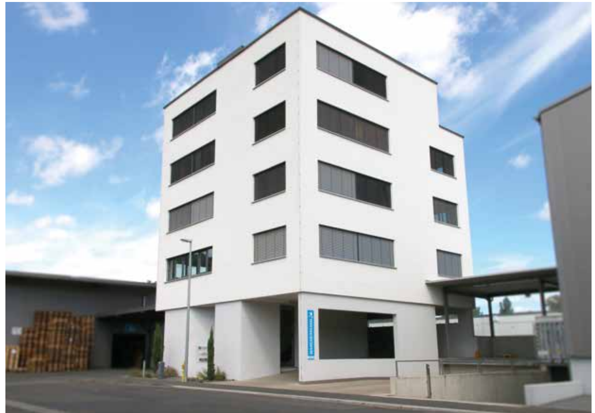
>> Bürogebäude Ludwig-Weis-Straße 12 Bestand
